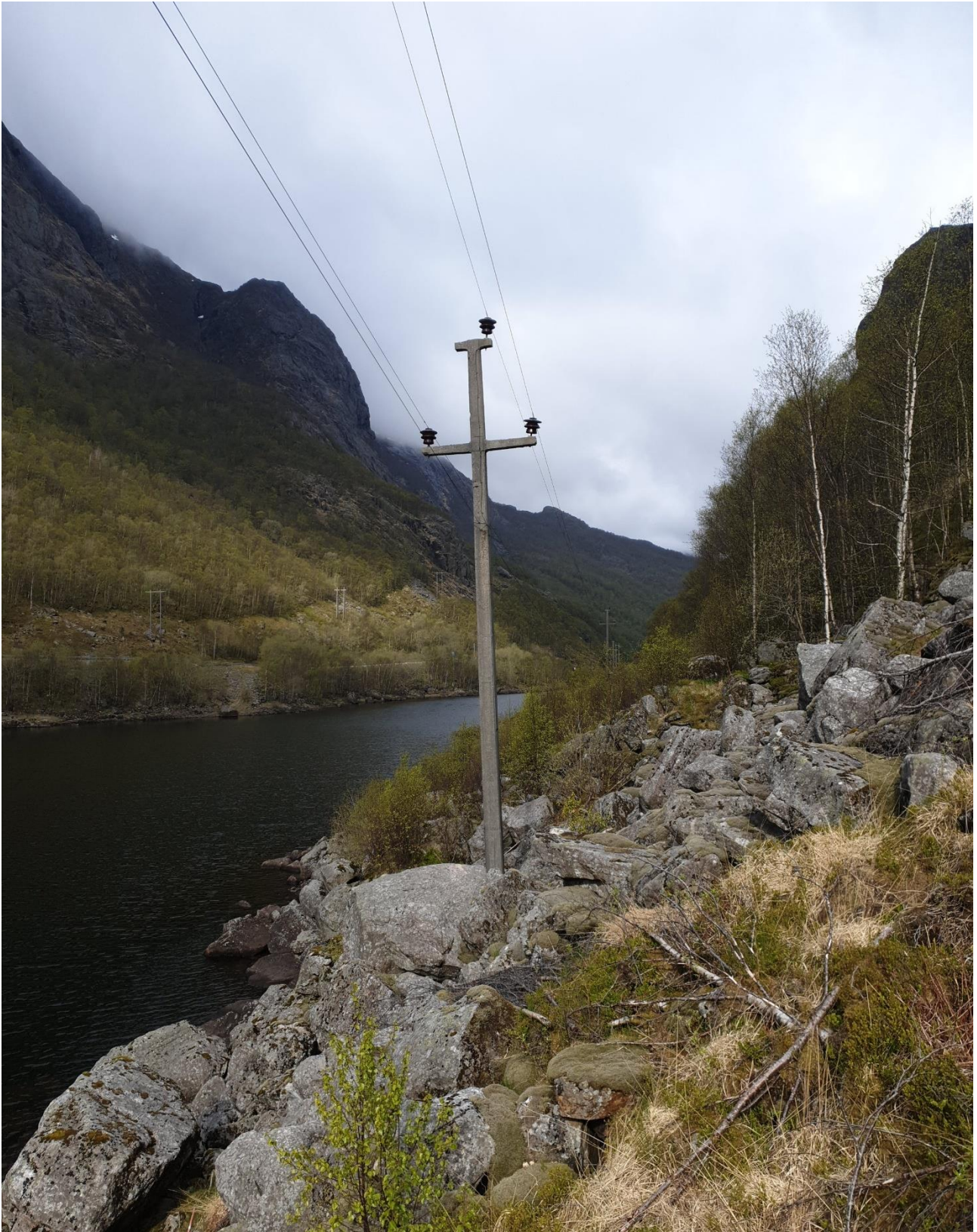
Figur 2 Maudal-Oltedal M48 ved Byrkjedalsvatnet, hvor det er aktuelt å la fundament stå igjen pga. utfordrende adkomst
