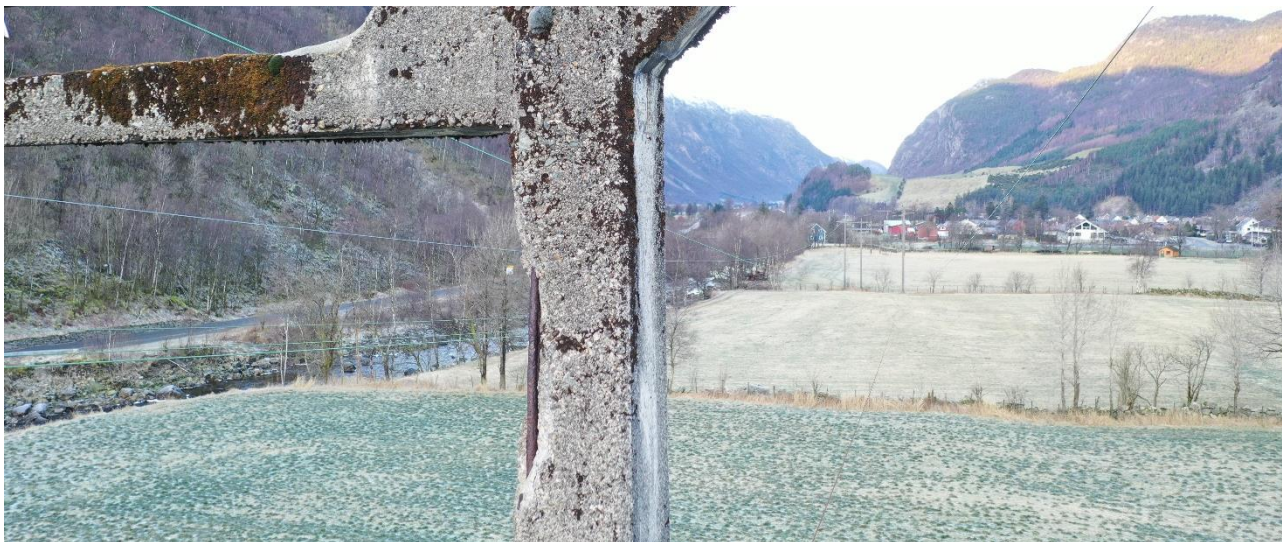
Figur 1 Maudal-Oltedal M74, øvre del av masta der betongen er forvitret og armeringsjern kommer frem
