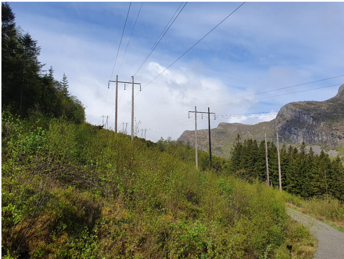
Figur 3: Dagens 50 kV ledning på strekningen Rage–Oltedal. Kilde: E-post fra Børre Dybesland i Lnett, 2. desember 2024.
