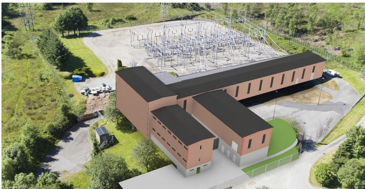
Figur 4 Ullandhaug transformatorstasjon med tilbygg
