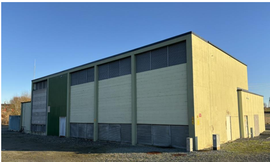
Figur 5-5. Bilde av eksisterende Risavika transformatorstasjon fra september 2024.
