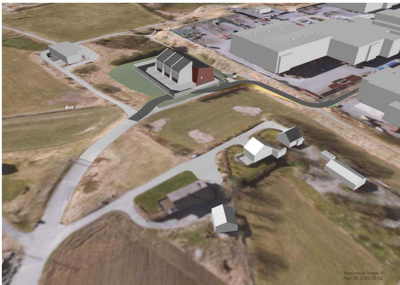
Figur 10-2. Tjora transformatorstasjon sett fra øst.
