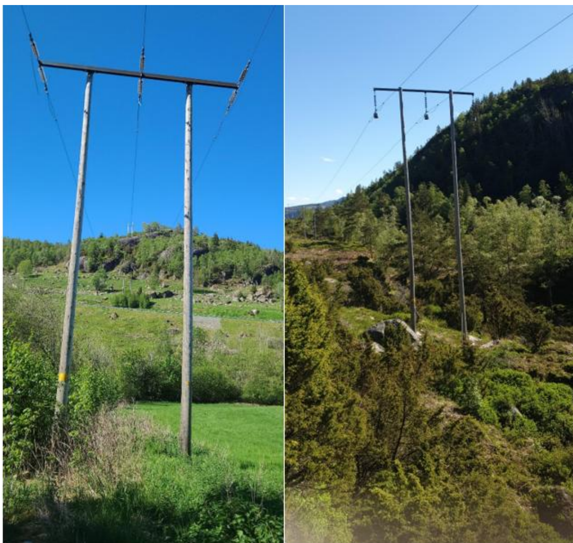
Figur 6-1 Bilder av aktuelle mastetype som skal rives
