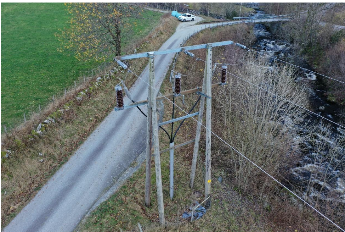
Figur 2 Foto av mast 50 der luftledning går over i jordkabel ved Bygdavegen
