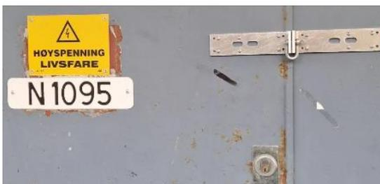
Bilde viser dør med to låser, der ekstralås er ettermontert. Sjakkell blir erstattet med hengelås våren 23.
