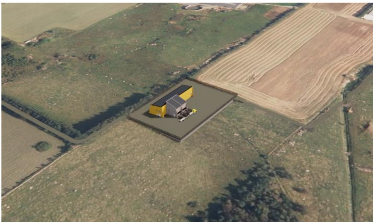
Figur 1 Tjøtta transformatorstasjon - sett fra sør
