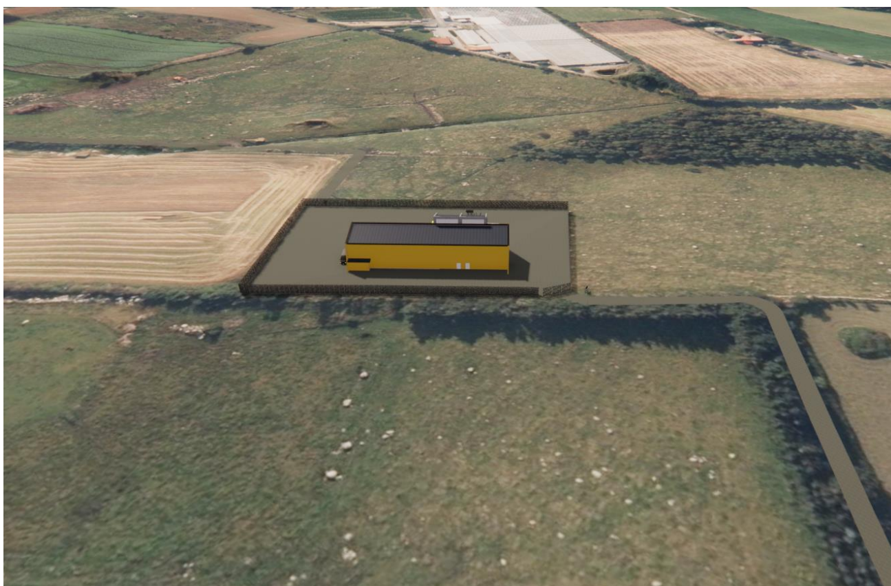
Figur 6 Tjøtta transformatorstasjon - sett fra nordvest
