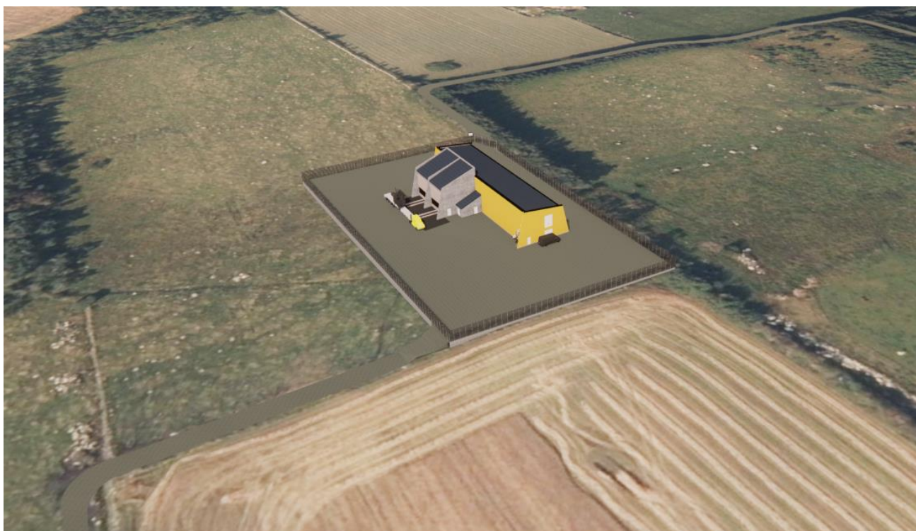
Figur 2 Tjøtta transformatorstasjon - sett fra øst
