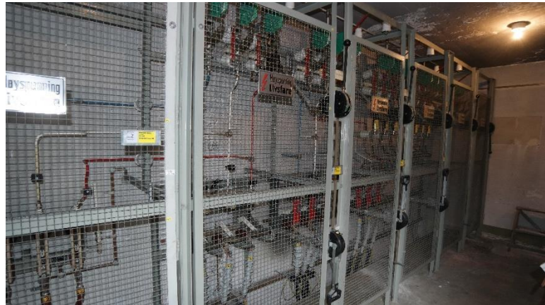
Figur 7 Høyspentanlegg
